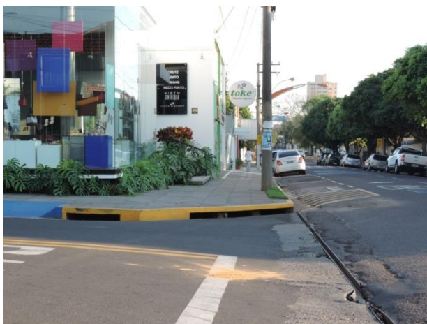
Foto 52 e 53 – Sarjetas, Meios-fios e Bocas de lobo existentes em ruas de Birigui Fonte: PROJEC (2015)
