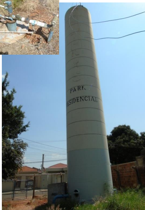
Foto 28 - Poço Colinas I e Reservação
