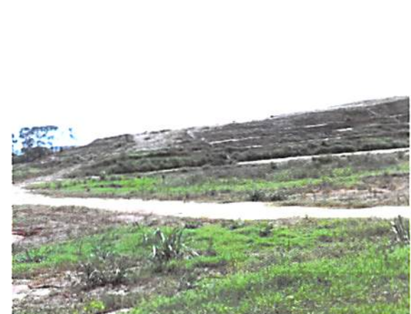
Foto 43 - Vista parcial do aterro sanitário Fonte: PROJEC (2016)
