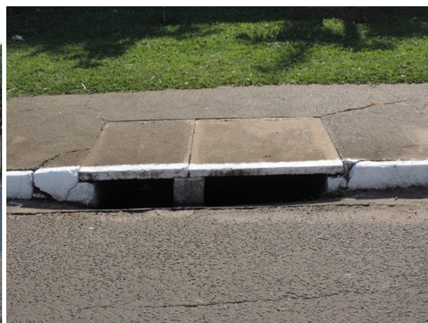
Foto 52 e 53 – Sarjetas, Meios-fios e Bocas de lobo existentes em ruas de Birigui Fonte: PROJEC (2015)
