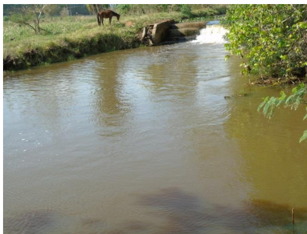
Foto 6 – Jusante da captação Fonte: PROJEC (2015)
