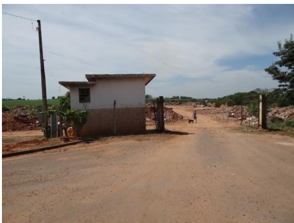
Foto 46 – Portaria do Aterro de Resíduos Inertes aberta, sem controle de entrada e saída Fonte: PROJEC (2016)
