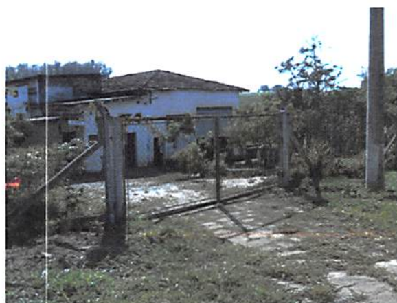
Foto 4 – Casa de máquinas Fonte: PROJEC (2015)
