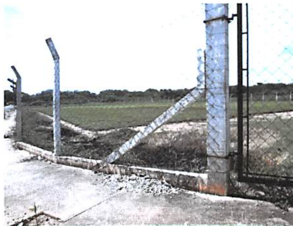
Foto 51 – Antigo Bolsão de entulho totalmente cercado
