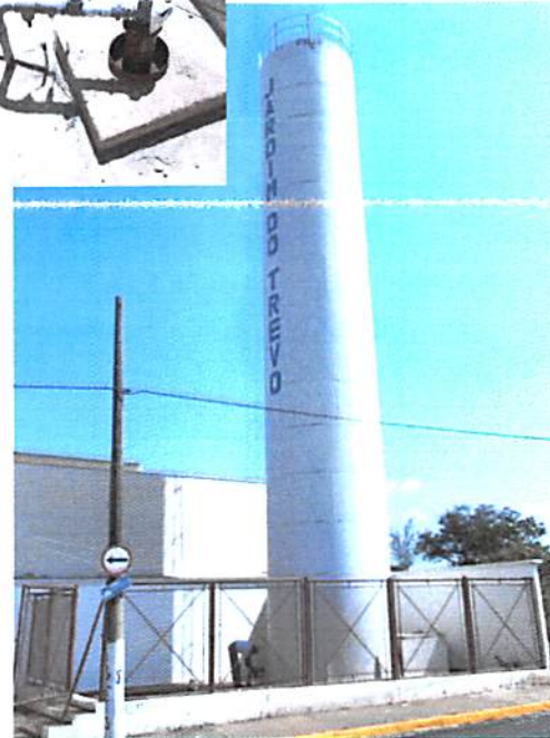
Foto 27 - Poço Jardim do Trevo e Reservação
