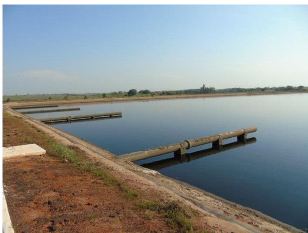
Foto 36 – Lagoa Anaerobia Fonte: PROJEC.
