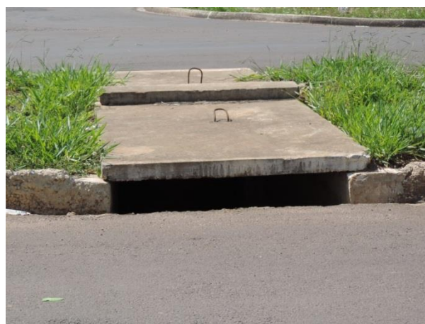
Foto 54 e 55 – Sarjetas, Meios-fios e Bocas de lobo existentes em ruas de Birigui Fonte: PROJEC (2015)
