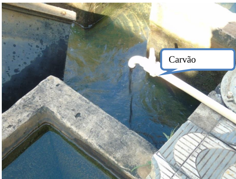
Foto 11 – Canaleta de condução da água para filtragem e adição de carvão ativado
