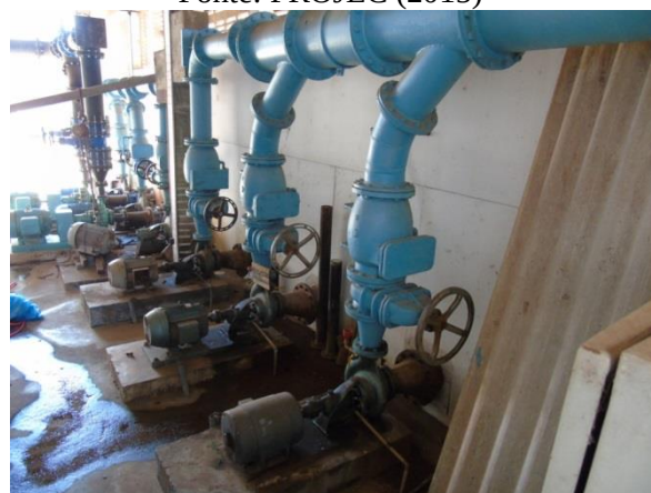
Foto 25 – Conjunto elevatório
