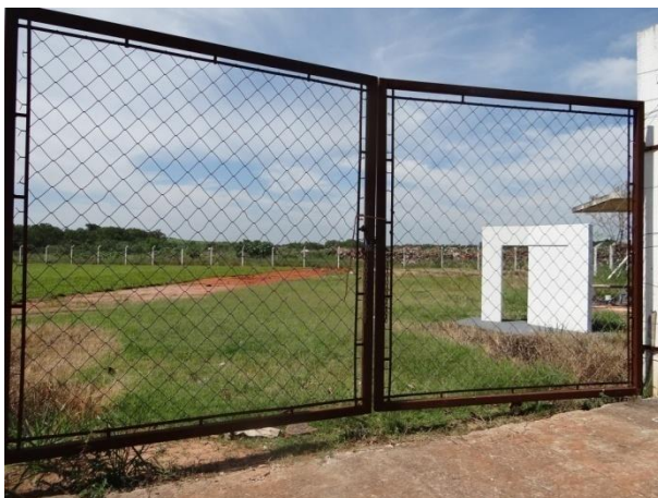
Foto 50 – Portão fechado do antigo Bolsão de entulho
