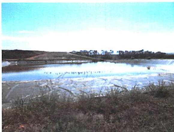
Foto 44 - Vista parcial do aterro sanitário e da nova vala impermeabilizada com manta Fonte: PROJEC (2016)
