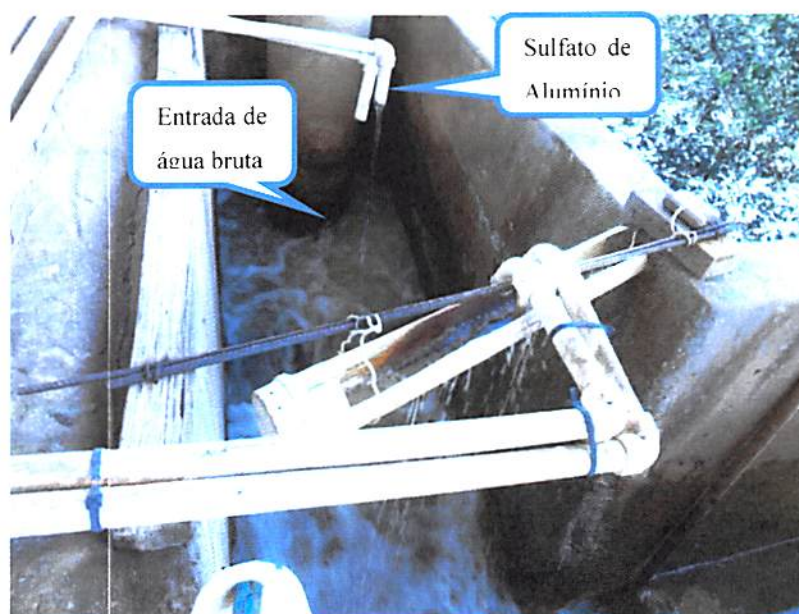
Foto 8 – Caixa de entrada da água bruta, adição de sulfato de alumínio por tubulação suspensa Fonte: PROJEC (2015)
