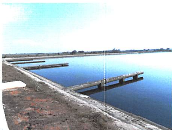
Foto 36 – Lagoa Anaerobia Fonte: PROJEC.
