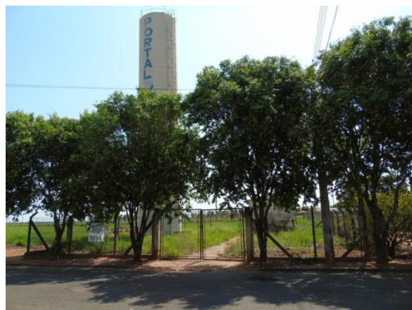
Foto 31 - Poço Portal I e Reservação Fonte: PROJEC (2015)
