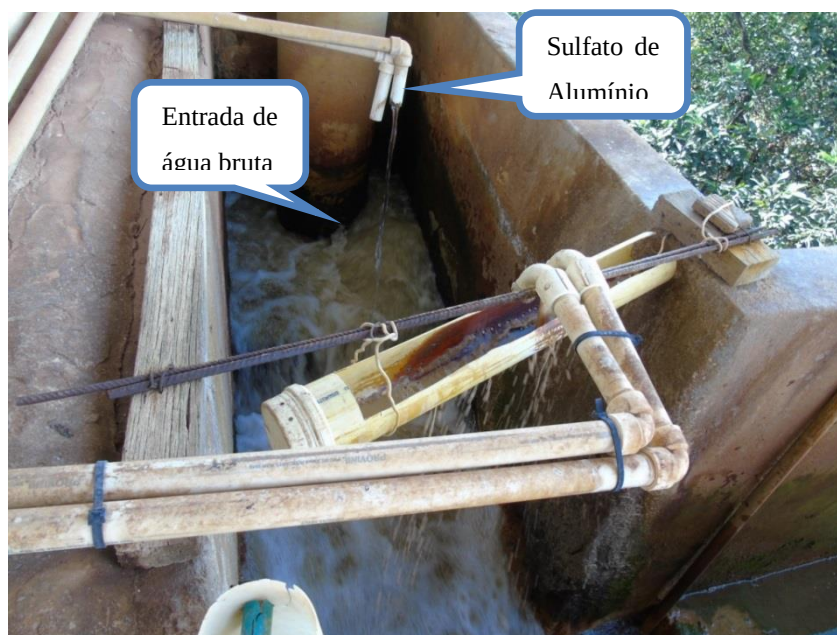
Foto 8 – Caixa de entrada da água bruta, adição de sulfato de alumínio por tubulação suspensa Fonte: PROJEC (2015)
