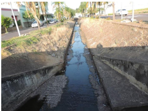
Foto 56 e 57 – Canais (córregos canalizados) a céu aberto na área urbana de Birigui Fonte: PROJEC (2015)
