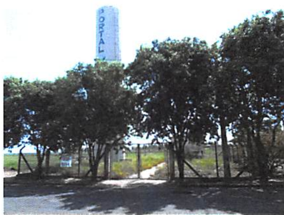
Foto 31 - Poço Portal I e Reservação Fonte: PROJEC (2015)
