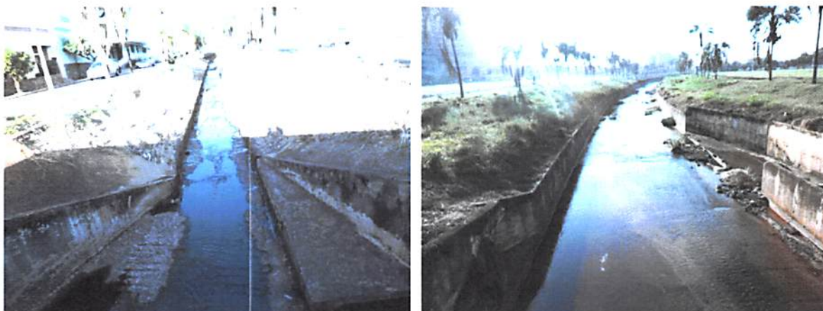
Foto 56 e 57 – Canais (córregos canalizados) a céu aberto na área urbana de Birigui Fonte: PROJEC (2015)
