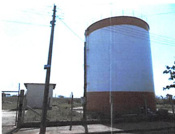
Foto 32 - Poço Portal II e Reservação Fonte: PROJEC (2015)
