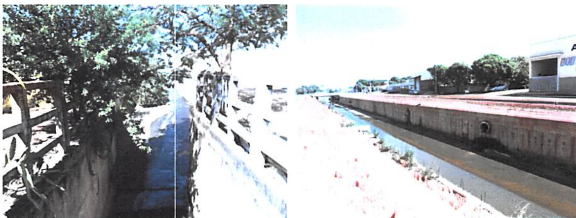
Foto 58 e 59 – Canais (córregos canalizados) a céu aberto na área urbana de Birigui Fonte: PROJEC (2015)
