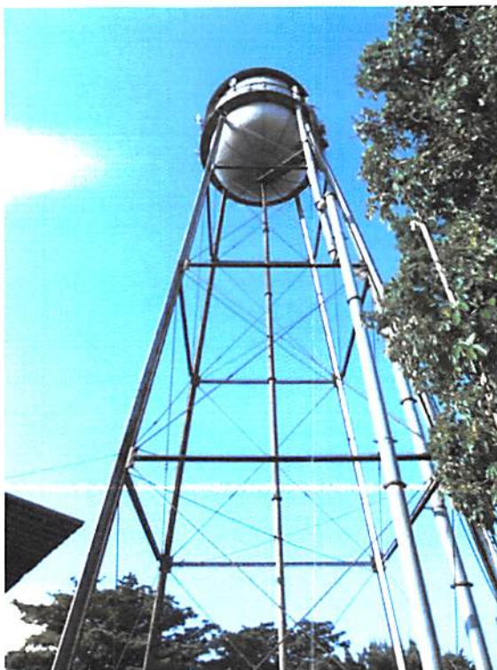
Foto 18 - Reservatório elevado Fonte: PROJEC (2015)
