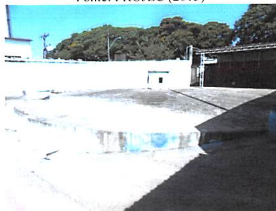
Foto 17 - Reservatório Saudade: Semienterrado Fonte: PROJEC (2015)
