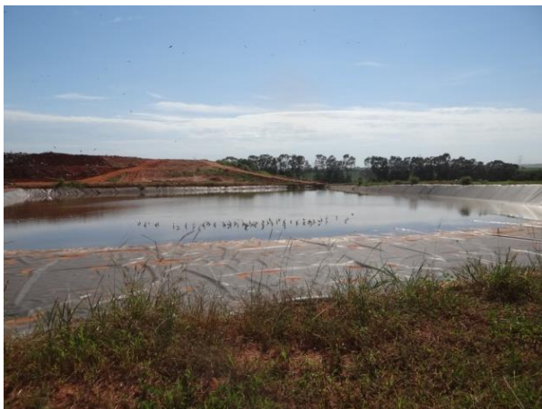
Foto 44 - Vista parcial do aterro sanitário e da nova vala impermeabilizada com manta Fonte: PROJEC (2016)
