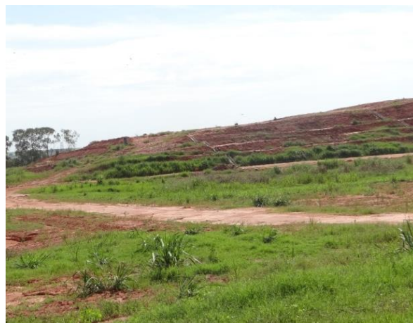
Foto 43 - Vista parcial do aterro sanitário Fonte: PROJEC (2016)
