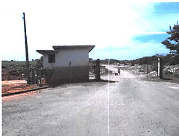
Foto 46 – Portaria do Aterro de Resíduos Inertes aberta, sem controle de entrada e saída Fonte: PROJEC (2016)
