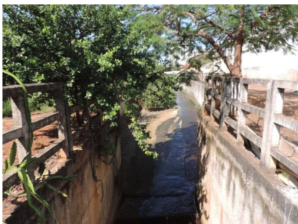
Foto 58 e 59 – Canais (córregos canalizados) a céu aberto na área urbana de Birigui Fonte: PROJEC (2015)
