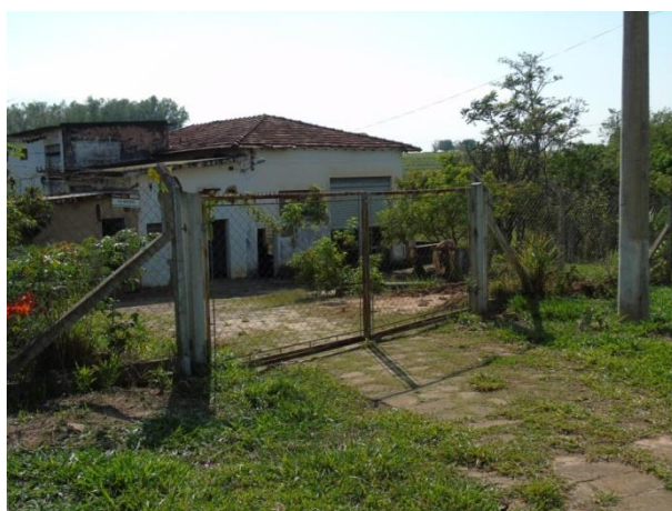
Foto 4 – Casa de máquinas Fonte: PROJEC (2015)
