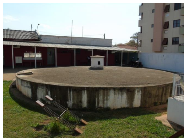
Foto 16 - Reservatório Saudade: Semienterrado Fonte: PROJEC (2015)
