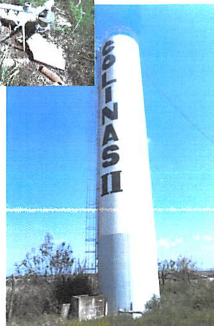
Foto 29 - Poço Colinas II e Reservação
