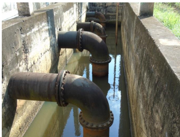
Foto 3 – Poço de sucção e conjunto de adutoras Fonte: PROJEC (2015)
