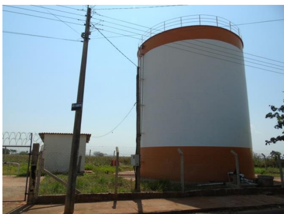
Foto 32 - Poço Portal II e Reservação Fonte: PROJEC (2015)
