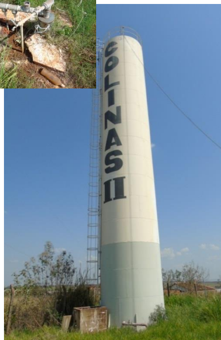
Foto 29 - Poço Colinas II e Reservação
