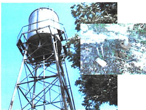
Foto 33 - Poço Taquari e Reservação Fonte: PROJEC (2015)
