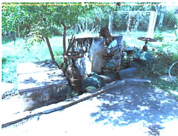
Foto 7 – Válvula antecipadora de onda – sistema desativado Fonte: PROJEC (2015)
