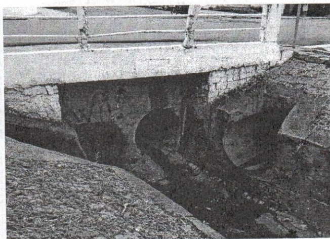
Foto 78: Vista geral das tubulações e da água que desce da nascente Data: 27/02/2019
